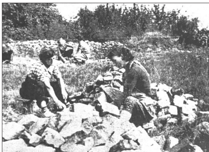
Auch am Zwickauer Damm gab es Trümmerfrauen, die hier aus Trümmern den Grundstock für das neue Vereinshaus zusammensuchen.
